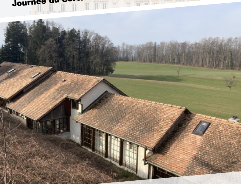
Appartements à Crêt-Bérard
